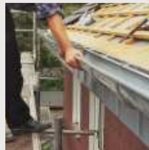
RHEINZINK®-takrennen sitter sikkert og varig etter å ha blitt klikket på plass
