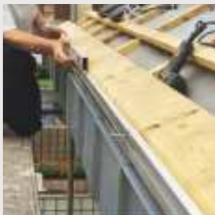
Kontroll av at underkonstruksjonen er i lodd og flukter nøyaktig
