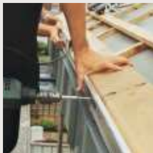
Montering av RHEINZINK®-renneskinne under takfot-flukter
