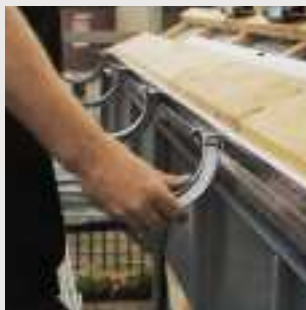
Dreibar rennekrok settes inn i monteringskinnen ved taksperrene
