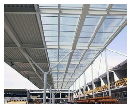
PC kanalplater til overlys tribunetak, Årnes Stadion
