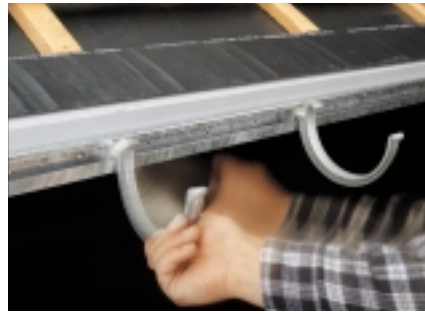
Dreibar rennekrok settes inn i monterings-skinnen ved taksperrene ved å vri dem på plass
