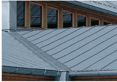
Vinkelrenne med hakefals og tilleggfsals
