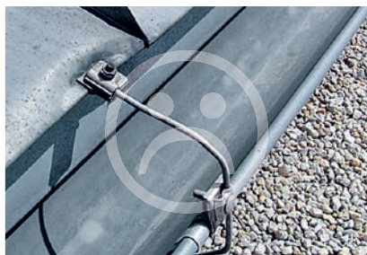
Lynsikring Ikke fest lynesikringen til rankene = Ekspansjonssprekker
