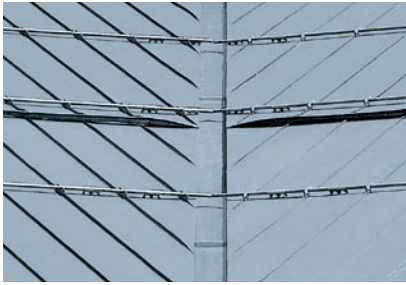
Vinkelrenne nedfelt på strukturmatte
