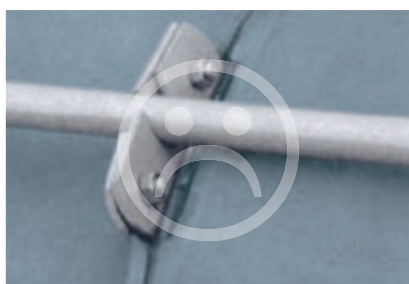
Snøfangesystem Feil montering på falsene
