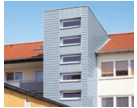
Bolig- og kontorbygg, Lehrte, Tyskland
