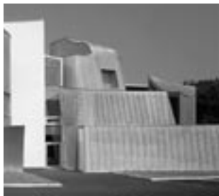
Fig. 2: RHEINZINK-overflate valseblank, VITRA administrasjonsbygning i CH-Birsfelden
