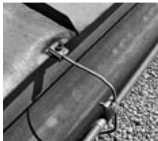
Fig. 14: Feilaktig tilkobling av lynvernklempen til banene
