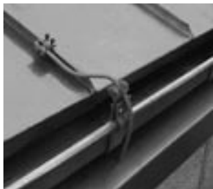
Fig. 13: Fagmessig korrekt tilkobling vil ikke hindre banenes termisk betingede lengdeendringer
