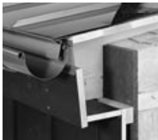
Fig. 8: Bruksområde: Takfotdetalj Tak med stående falser og strukturmatter
