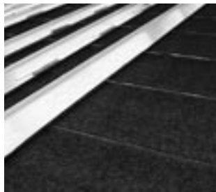
Fig. 9: Strukturmatter med fiberduk, legging på oversiden av trekonstruksjon
