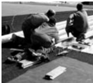
Fig. 10: Strukturmatte uten fiberduk, Enka®-Vent
