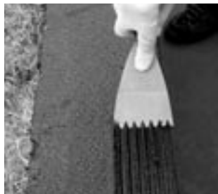
Fig. 5: Enkolit® påføres med rillet sparkel
