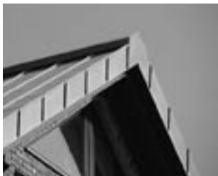
Fig. 18: Fluktende møneavslutning på vindskibeslag fals, lav utførelse
