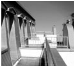
Fig. 30: Bruk av RHEINZINK-bygningsprofil som murbeslag
