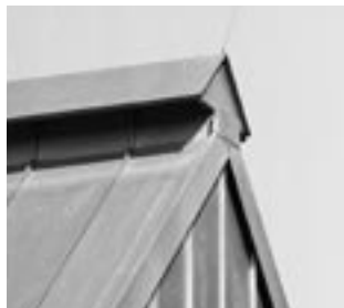
Fig. 17: Fluktende møneavslutning på vindski, høy utførelse
