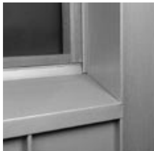
Fig. 26: Lysåpning til sideavslutning sålbenkbeslag
